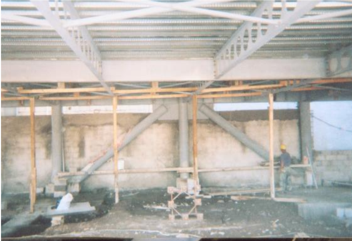
Vigas de alma perforada (prefabricadas comercialmente).
